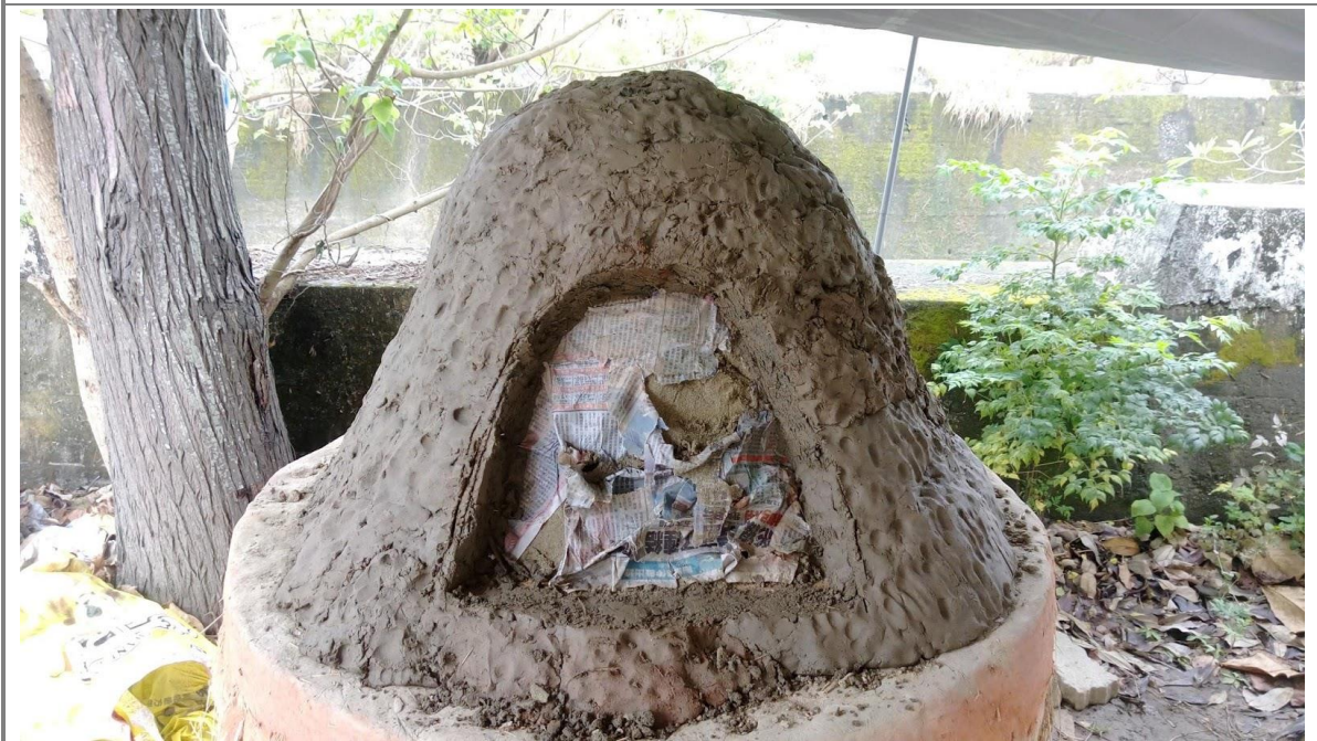
9. 陰乾幾天後開窯門(高度約窯高的 63%)並挖出沙子
