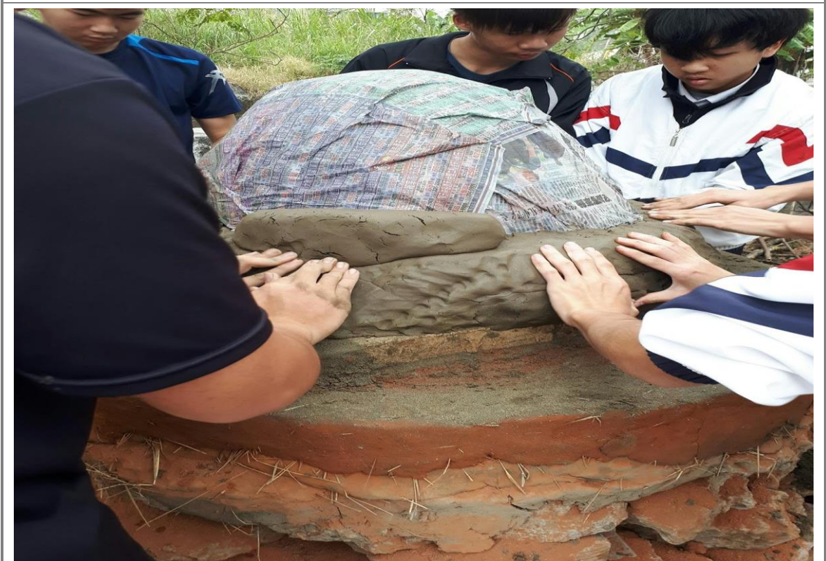
7. 鋪上濕報紙後，開始堆第一層蓄熱層(用手指將土壓實,不可用拍打方式避免出水)
