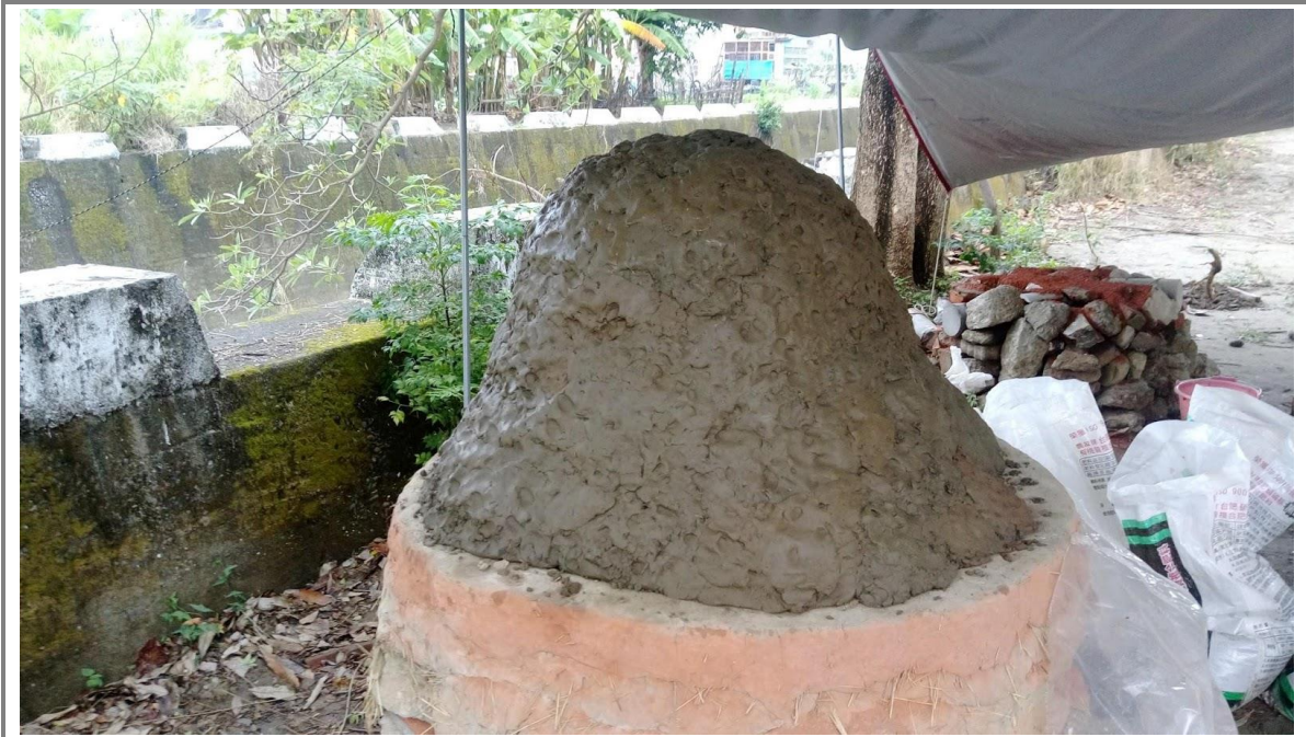
8.堆第二層隔熱層(除了砂及土外加入麥稈)
