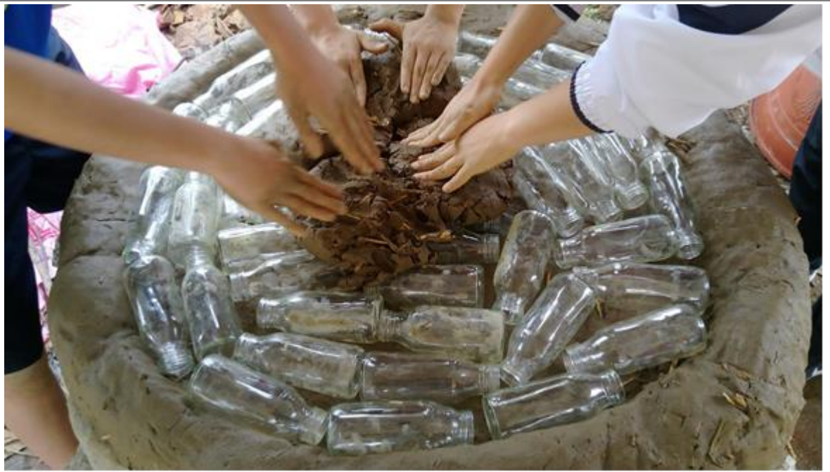
4. 蓄熱層玻璃瓶鋪設
