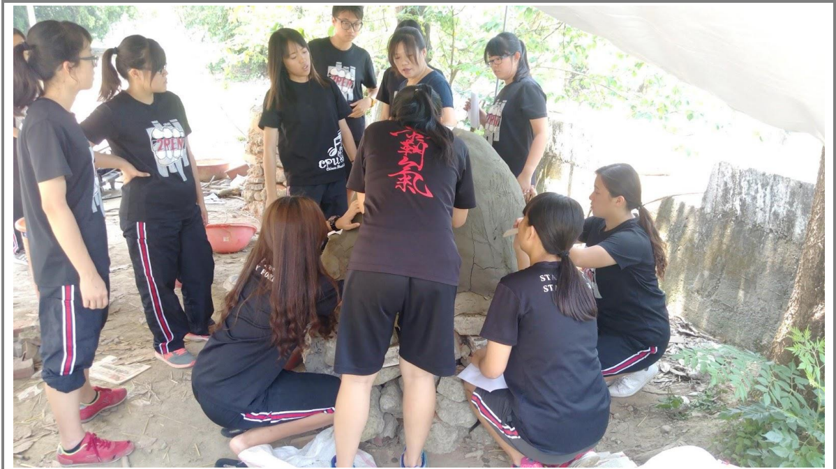
10. 第三層窯土裝飾並試燒(用小火慢慢將窯體烤乾避免用大火以免窯體受損)
