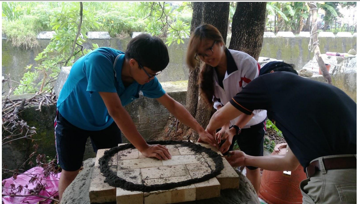
5. 鋪設耐火磚 (注意水平) p.s.防火磚上黑色圈圈為沙模搭設的底部大小
