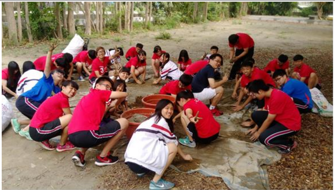
3. 土條製作 (鋪防火磚下方蓄熱層)
