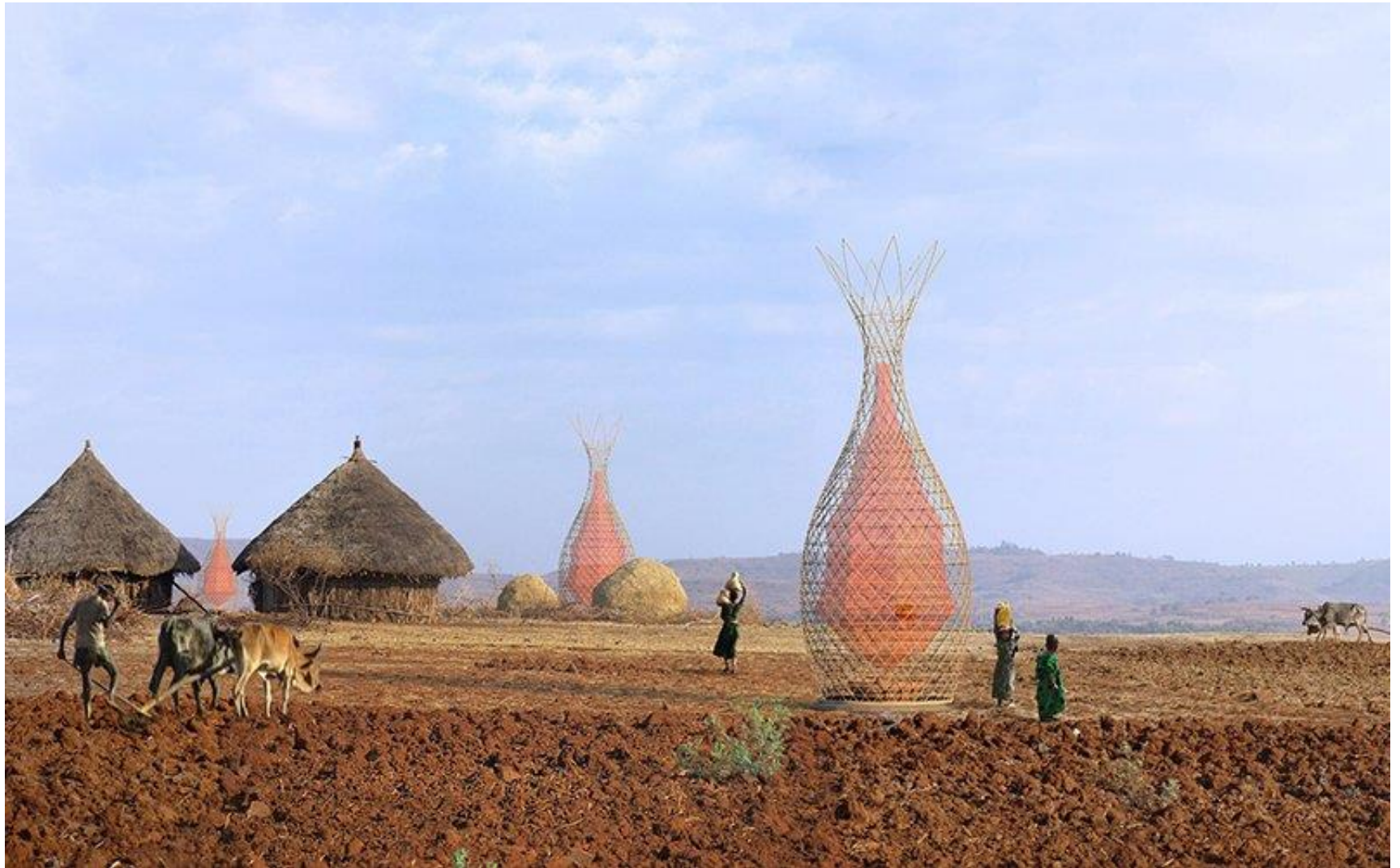
義大利籍的建築師 Arturo Vittori 打造的WarkaWater 從空氣中蒐集水分 http://npost.tw/archives/21858
